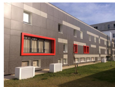
CHS La passerelle de l'espoir- Villejuif
